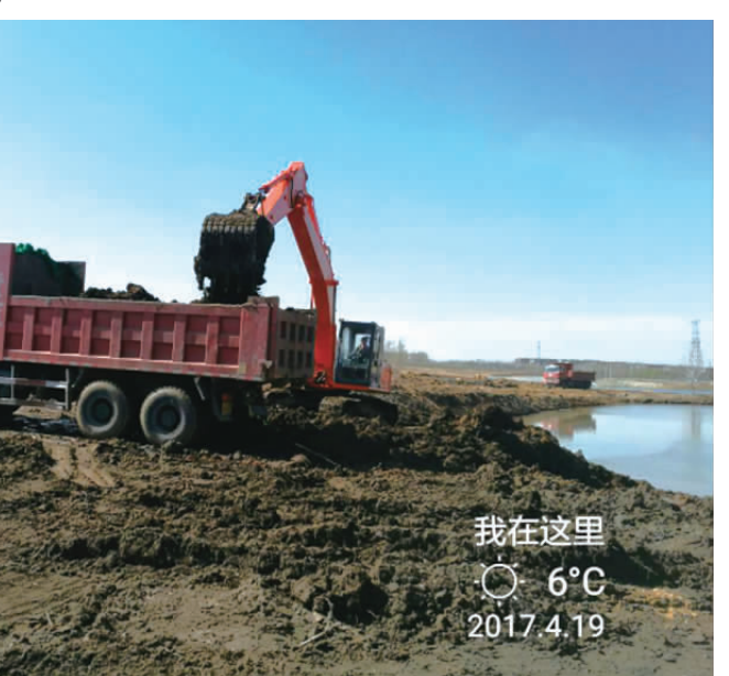
4月14日至4月22日，地产公司工程部对金正项目人工湖进行了扩建和改造，并将原有人工湖南侧不平整的边坡进行了美化修整，修整后人工湖面积扩大约1500m²。经改造后的人工湖，将有力的提升项目地块的品牌价值，成为未来地块景观带的重要组成部分。(华正地产 刘野)
